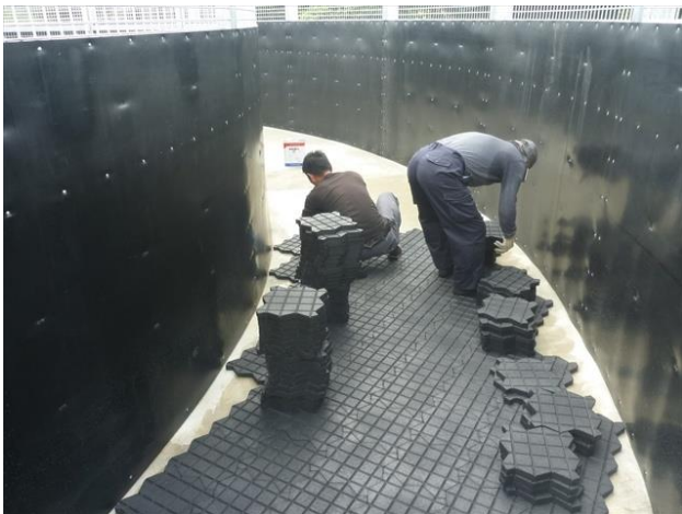
ゴムブロック施工風景
