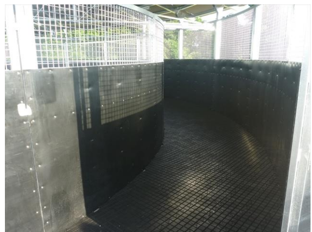
ゴムブロック施工後
