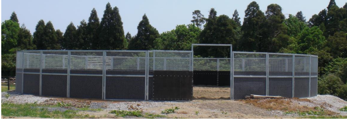
直径15m [ネットパネル26枚] の設置例 (下部のみゴム張)
