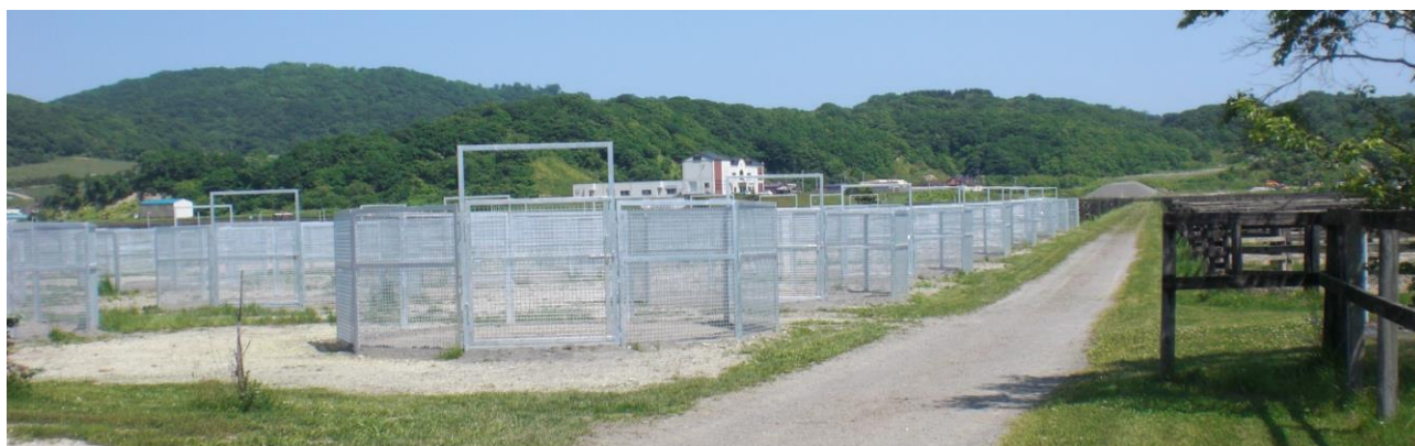
牧柵を撤廃し、弊社製サンシャインパドックを施工 施工場所：北海道育成牧場（40基）
